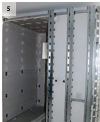
Die abgehängte Decke aus GK sorgt für die Aussteifung des Raumes. Fixpunkte zur Decke werden nur im Türbereich ausgeführt.
