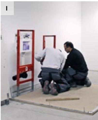
Der Bestandsboden wird vor dem abgestimmten Installationsschacht mit einem Bodenblech versehen, welches der Garant für die passgenaue Ausführung ist.
