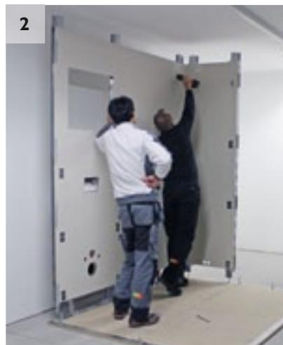
Nach erfolgter Rohinstallation werden die Umschließungswände aus vorkonfektionierten Wänden mit dem ausgelegten Bodenblech verbunden und verschraubt.
